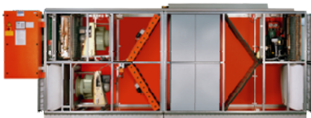
Slika 16-Klimatska naprava Hall Terme Zreče
