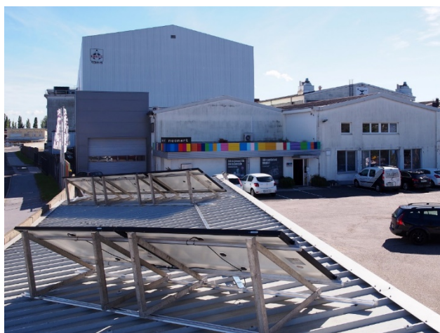
Slika 13: Sončna elektrarna na sedežu podjetja projektnega partnerja.
